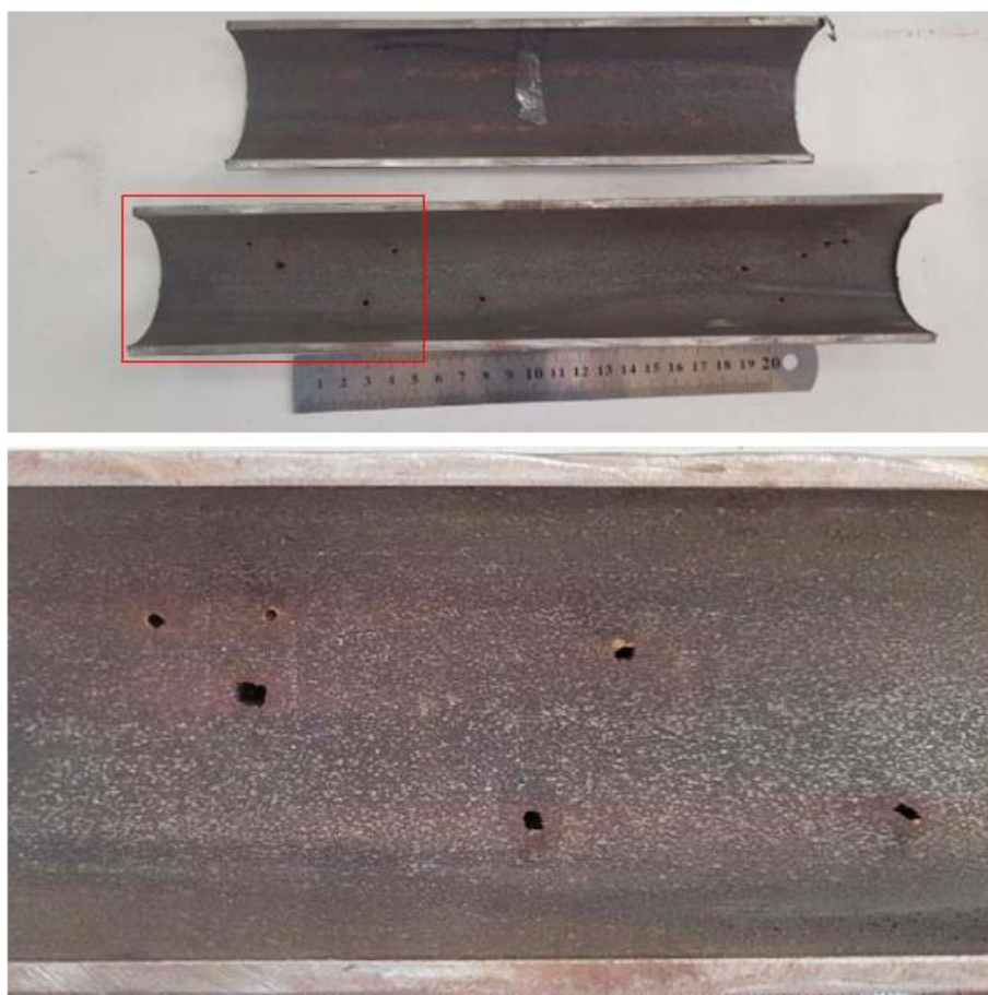
شکل ۳ - سطح داخلی نمونه لوله
